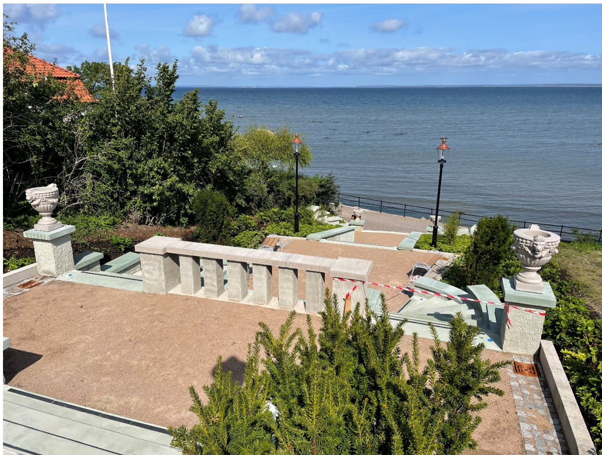
Den 2 september invigdes Lejongapstrappan på nytt efter en omfattande renovering. Projektet har genomförts i samarbete med Föreningen Lejongapstrappan, vars donatorer beräknas stå för drygt hälften av finansieringen tillsammans med Stiftelsen Gripen och Länsstyrelsen.
