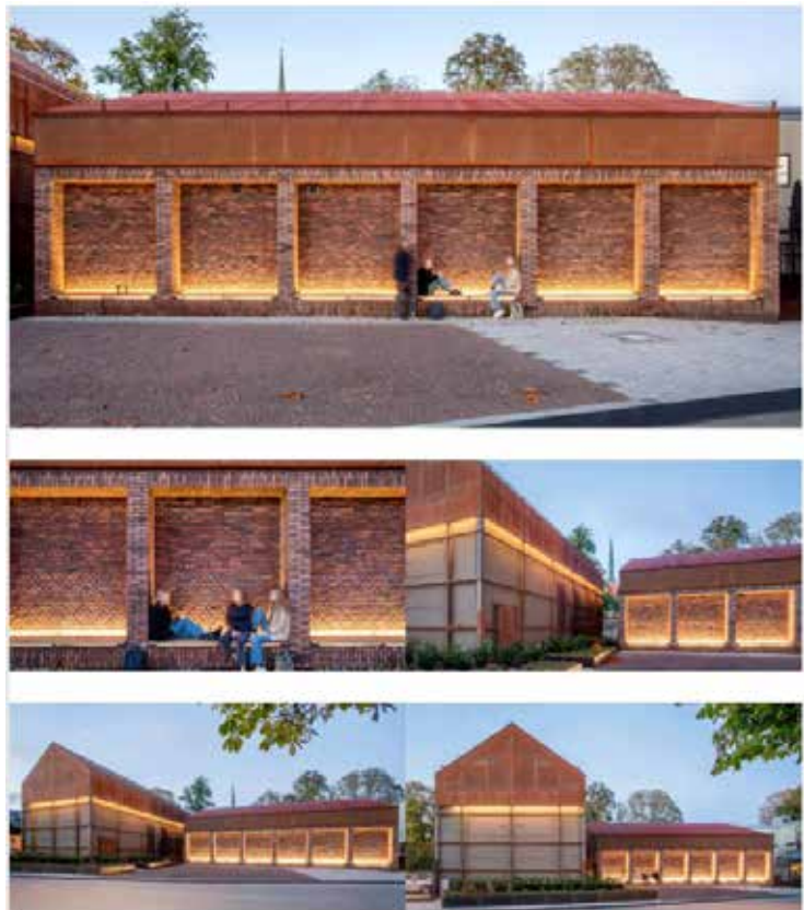
Inbyggt ställverk i Växjö, kv. Elverket - Inspirationsbild
