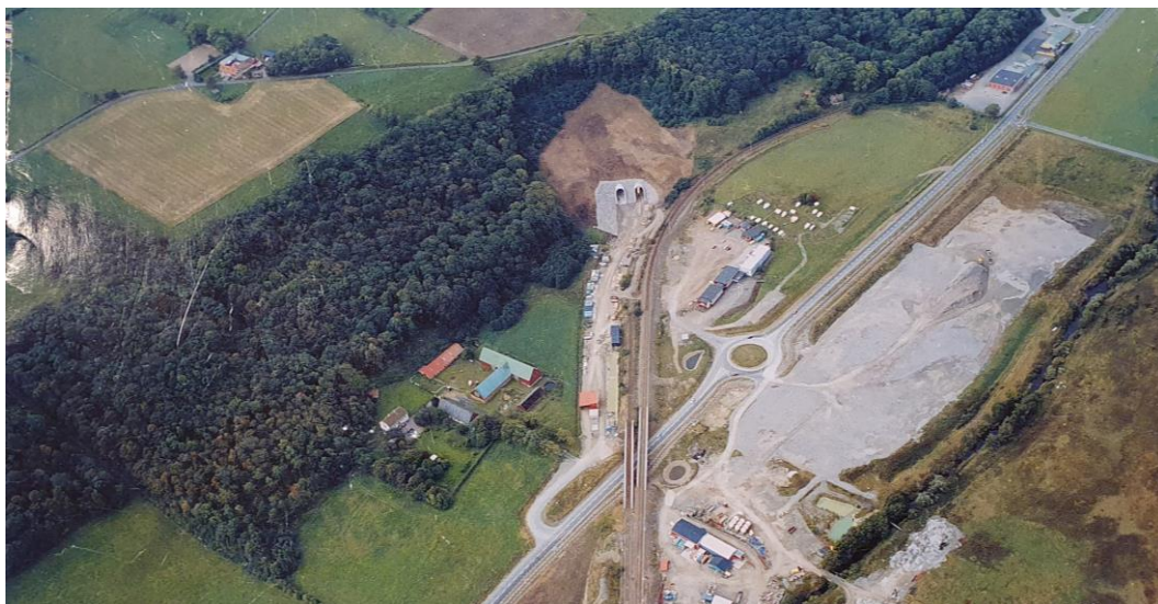
Flygfoto i samband med framtagande av Miljökonsekvensbeskrivning, Projekt Hallandsås, år 2000
