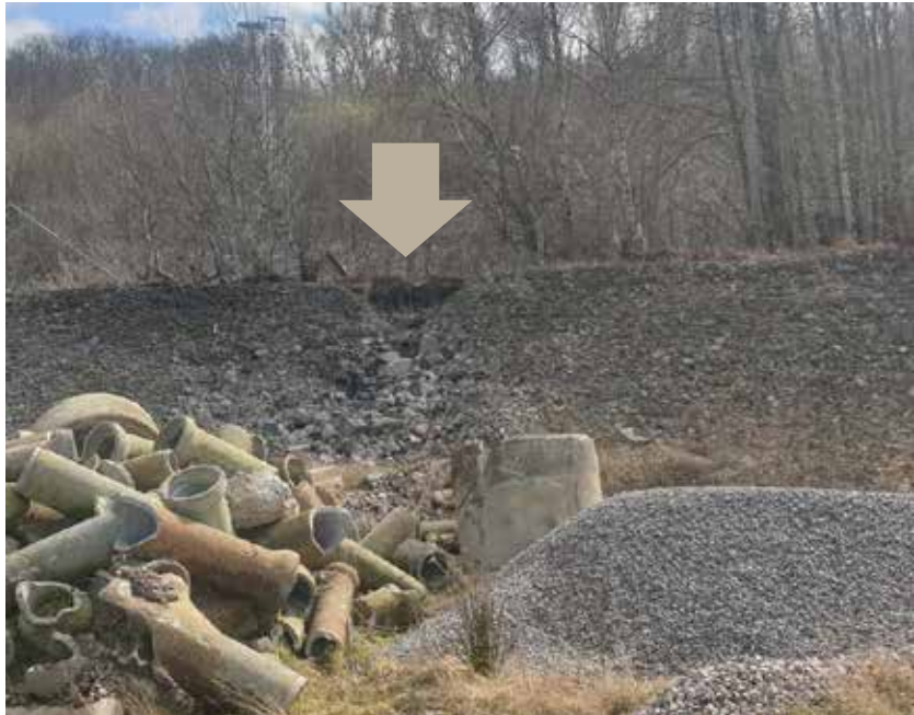
Bildtext: Visar den plats på banvallen där man ser att gruset sköljts bort.
